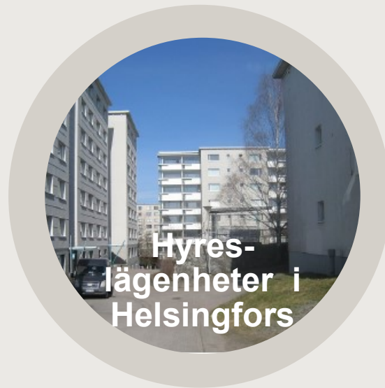
Renovering av hyresbostäder (17 MEUR)
