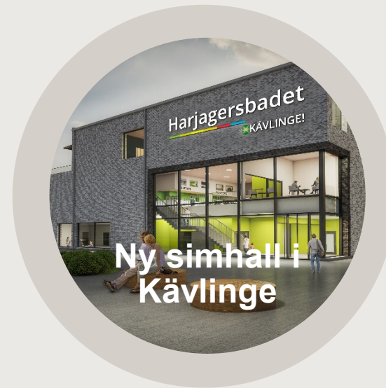
Byggnation av nytt badhus (292 Mkr)
