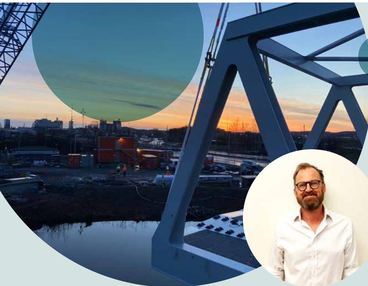
Mats Ek, biträdande projektledare Olskroken planskildhet, Trafikverket
